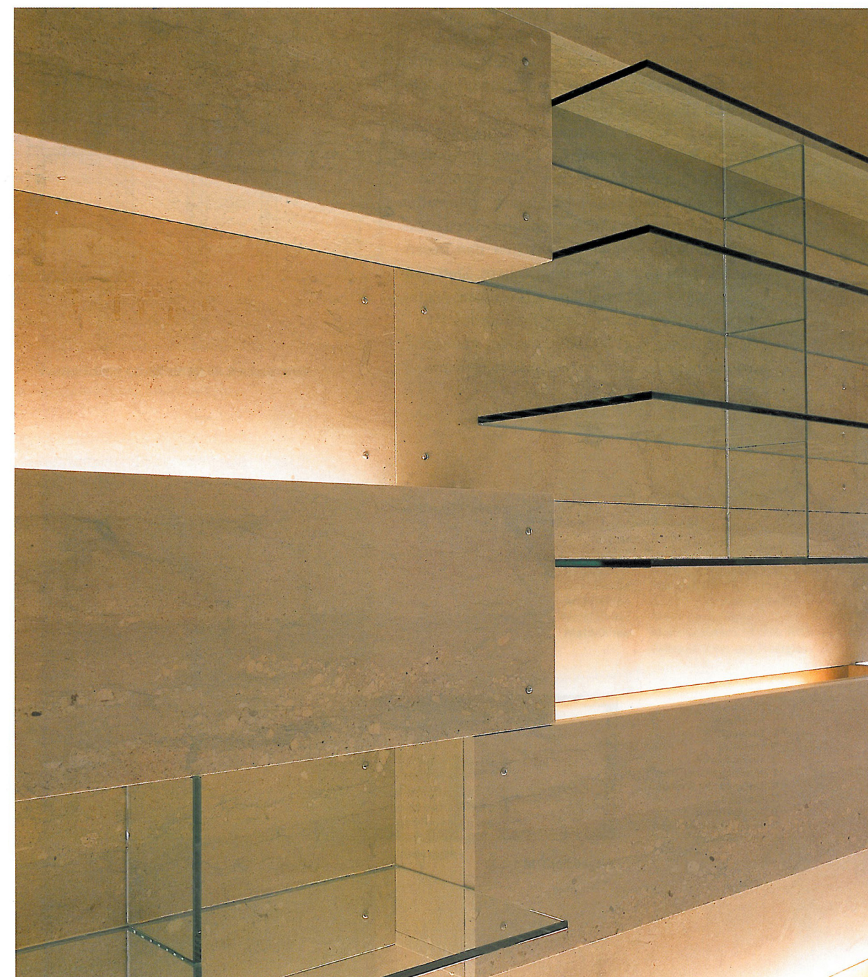
Hinterleuchtete Vor- und Rücksprünge aus Marmor und Regalböden aus Floatglas dienen der effektvollen Präsentation der Produkte
