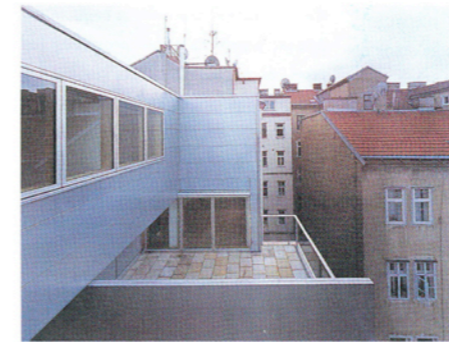
Terrasse sur cour au 4 e niveau
