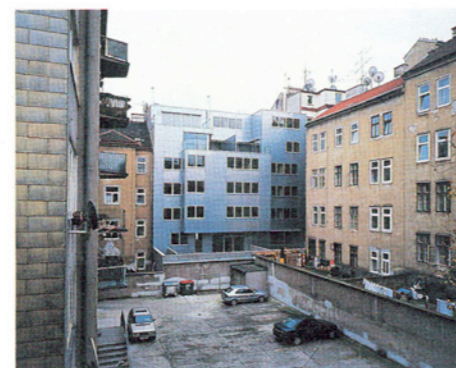
Façade sur cour
