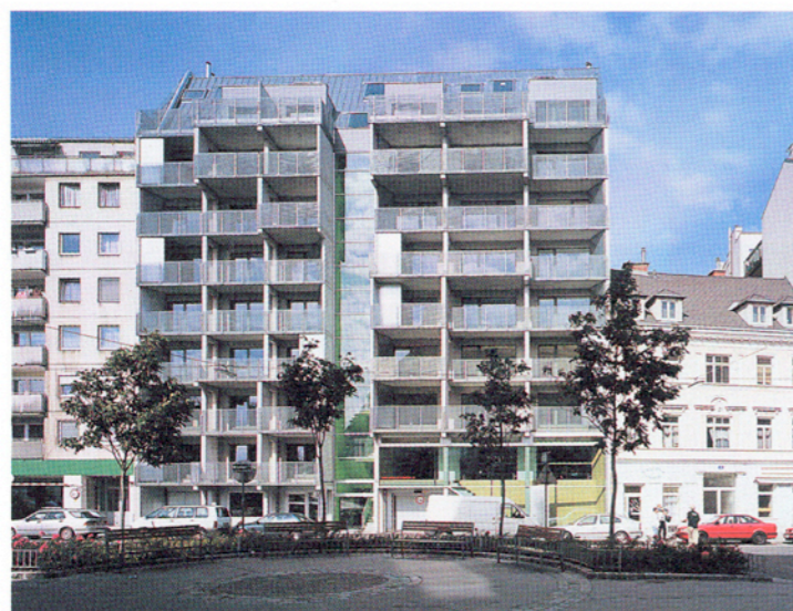
Chacun des vingt-huit logements dispose d'une loggia
