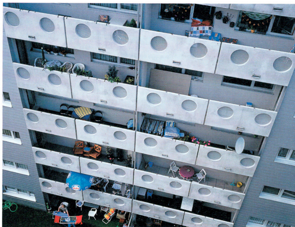
Le motif des garde-corps perforés est répété sur toutes les façades de cet ensemble de 404 logements
