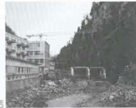
DR Vue du site avant transformation.
