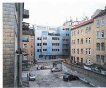
Façade sur cour
