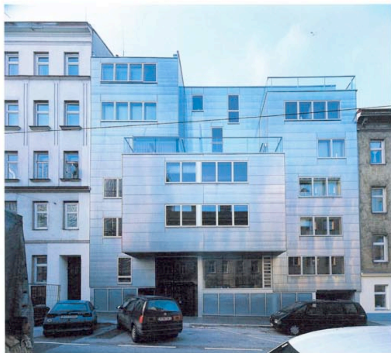
La façade sur rue est animée par l'imbrication de plusieurs cubes revêtus de feuilles d'un alliage titane-zinc
