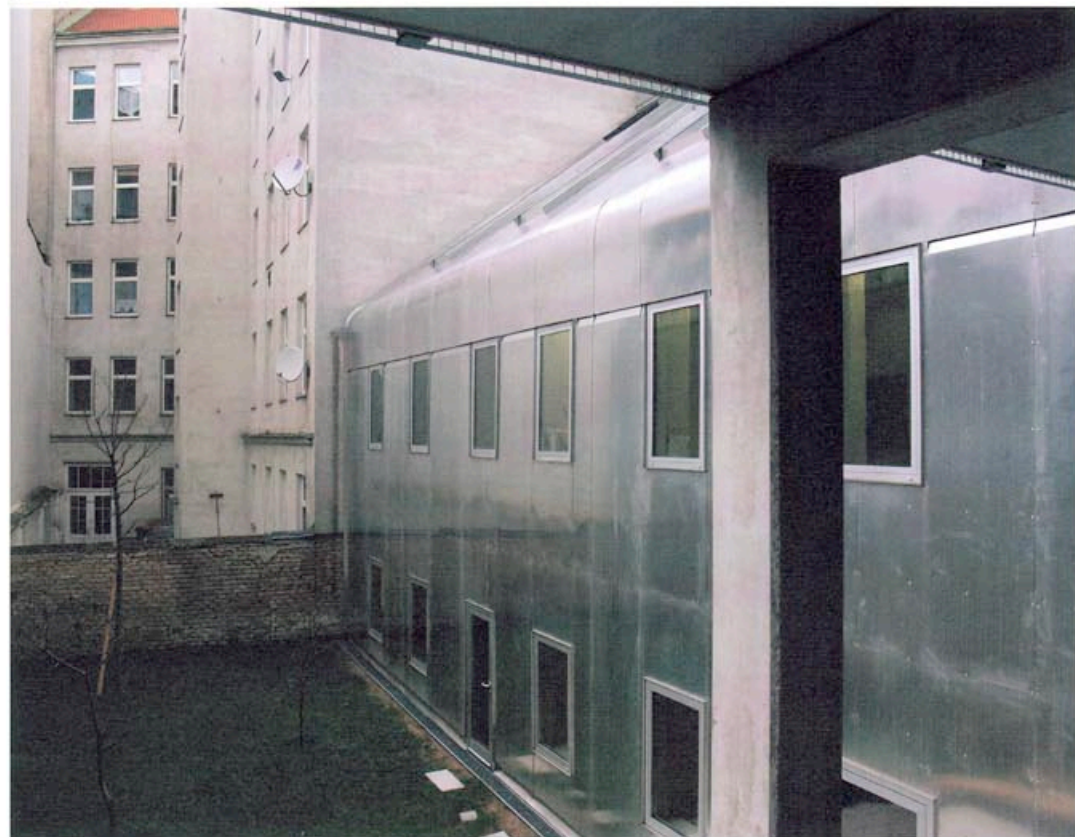
Les architectes ont rénové une vieille maison sur cour d'époque Biedermeier en la couvrant d'une peau en tôle
