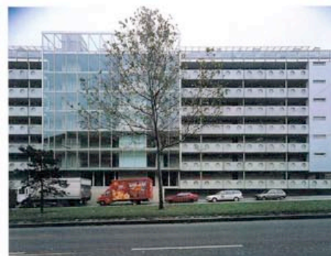
À l'est, la façade est composée d'éléments préfabriqués en béton et de jardins d'hiver
