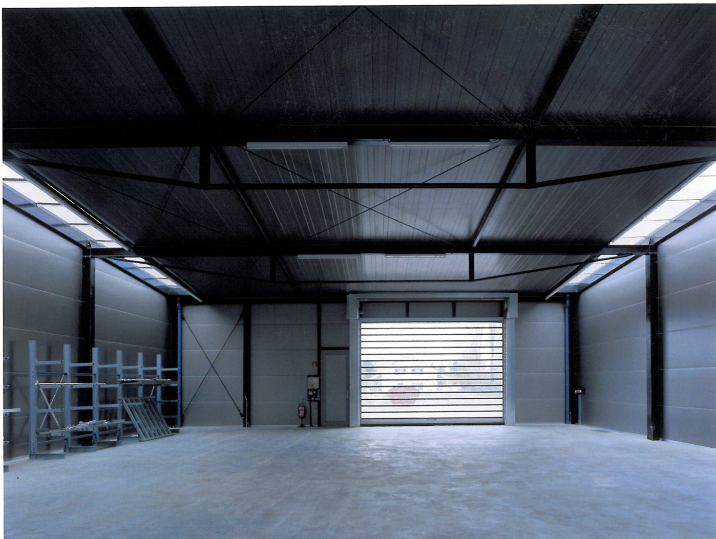
10 Im Inneren herrscht logische Klarheit und offen liegende Konstruktion. Die Materialien: Stahl, Beton, Glas. The interior of the building is marked by logical clarity and the exposed structure. The materials used are steel, concrete and glass.
