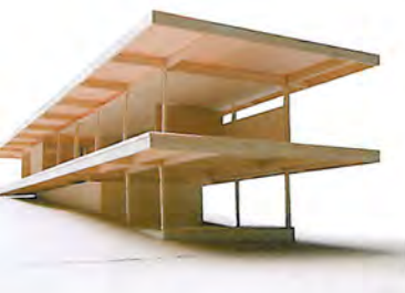
Oben Das Konstruktionsprinzip aus Boden und Deckel.
