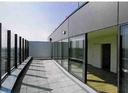
Dachterrasse Roof terrace
