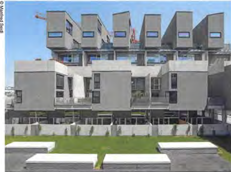
ARTEC Architekten: Tokiostraße – Die Bremer Stadtmusikanten, Wien-Donaustadt (22. Bezirk) 2009 Die Stapelung verschiedener Wohnungstypen mit jeweils zugeordneten Freiräumen bildet den volumetrisch gegliederten Baukörper dieses Terrassenhauses.
