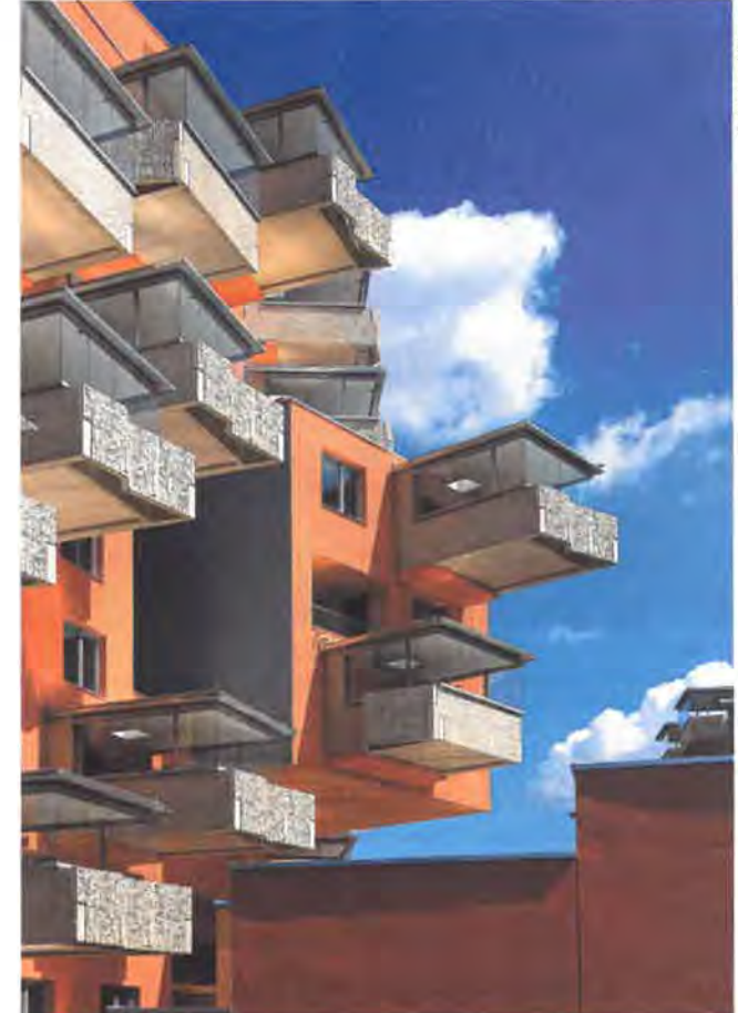
Die äußere Gestalt des Gebäudes wird durch Terrassierungen, Einschnitte und auskragende, überdachte „Veranden“ gegliedert.
