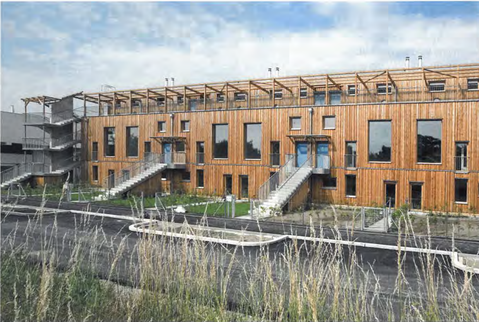
Hermann Czech: Wohnen am Mühlgrund, Wien-Donaustadt (22. Bezirk) 2011 Die Gebäudekonzeption beruht auf einer besonderen Interpretation der Wiener Bauordnung. Gemäß der Bauklasse I ist eine Gebäudehöhe von 7,50 Meter (zuzüglich eines Staffelgeschosses) zulässig. Diese Begrenzung der Gebäudehöhe hat den Sinn, ein drittes Vollgeschoss zu verhindern.
