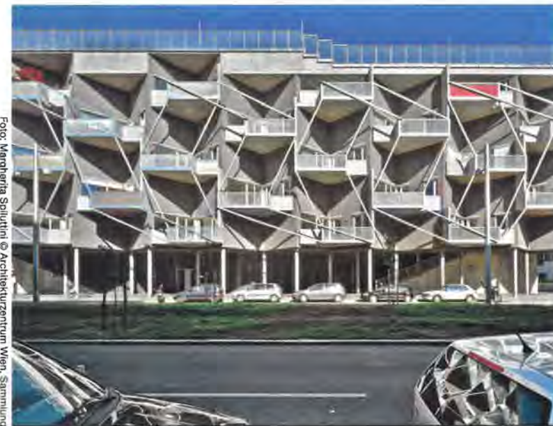
Straßenansicht der eingeschossigen Wohnungen mit einem zweigeschossigen Loggienraum (Casablanca-Typologie)
