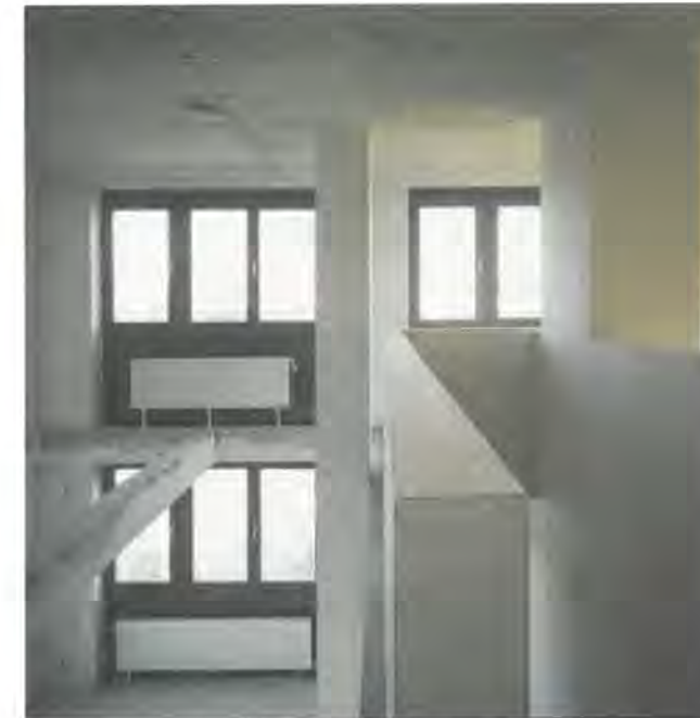
Eine zweigeschossige Lofteinheit besteht aus einem Installationskern und einer Treppe. Die obere Ebene ist als Galerie geplant, lässt sich jedoch individuell und kostengünstig vergrößern, indem über zwei, beiderseits des Kerns eingebaute Unterzüge eine Decke gezogen werden kann.
