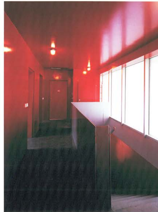
Wände, Decken und Türen sind hoch glänzend Rot lackiert, der gegossene, geschliffene Bitu-Terrazzo am Boden ist tiefschwarz.
