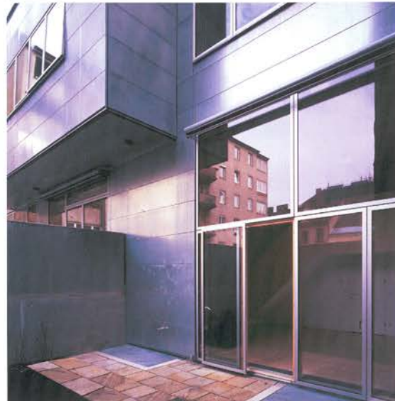
Die hinterlüftete Fassade wurde vollflächig mit Titanzinkblech verkleidet.
