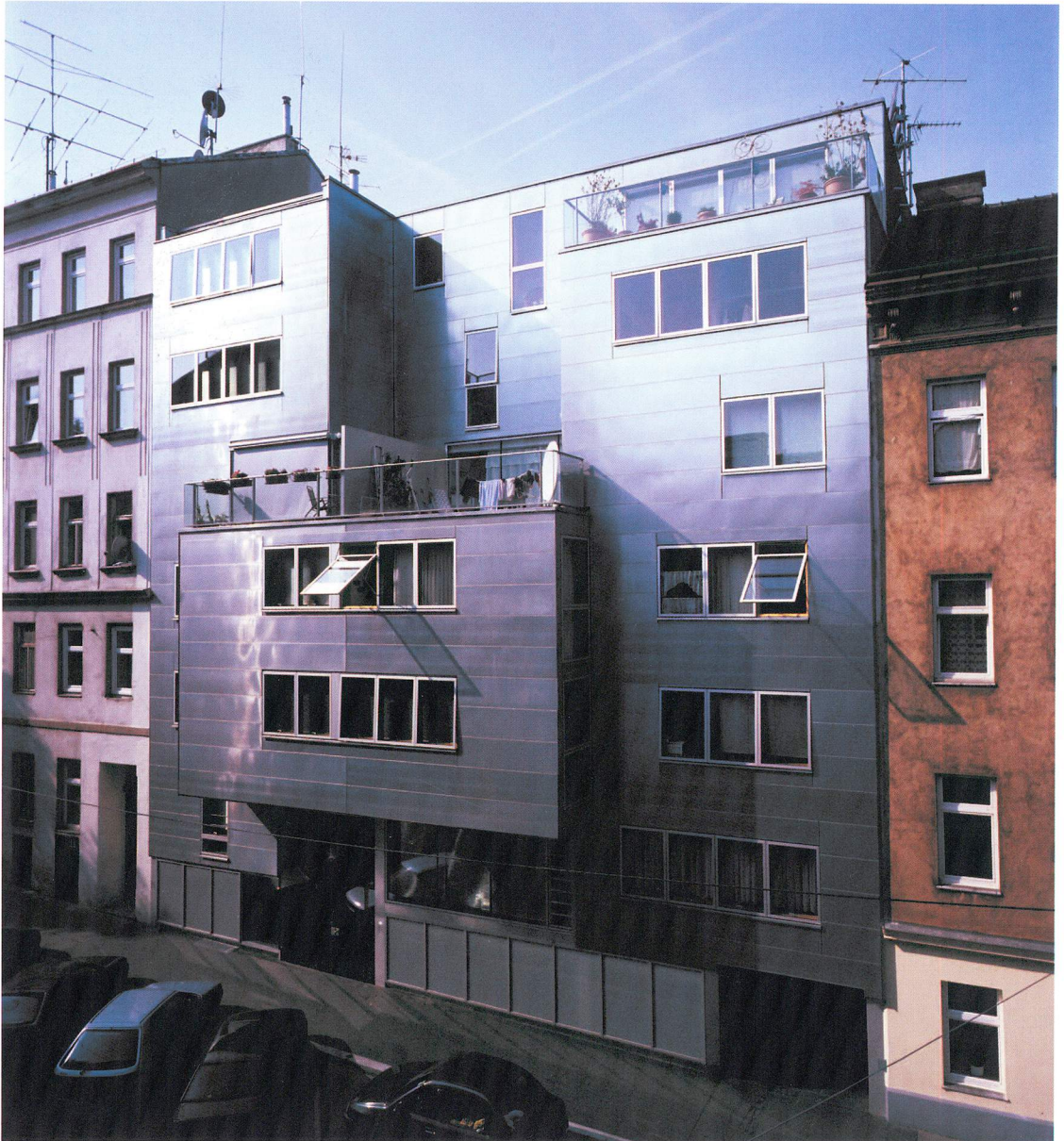
Vor- und Rücksprünge, Abtreppungen und Kerben kennzeichnen den plastischen Baukörper. Fotos: Margherita Spiluttini
