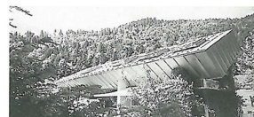
Kuća Manahl – Nüziders Vorarlberg, Austrija / Manahl – Nüziders House Vorarlberg Austria, 1986-1989.
