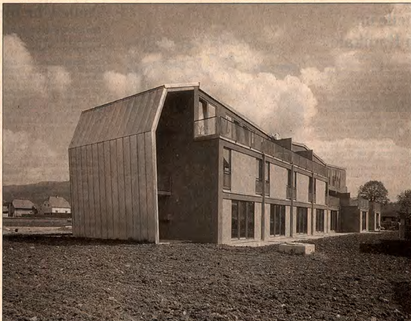
Tragende Querwände: Wohnbau von ARTEC in Bärnbach, Steiermark.
