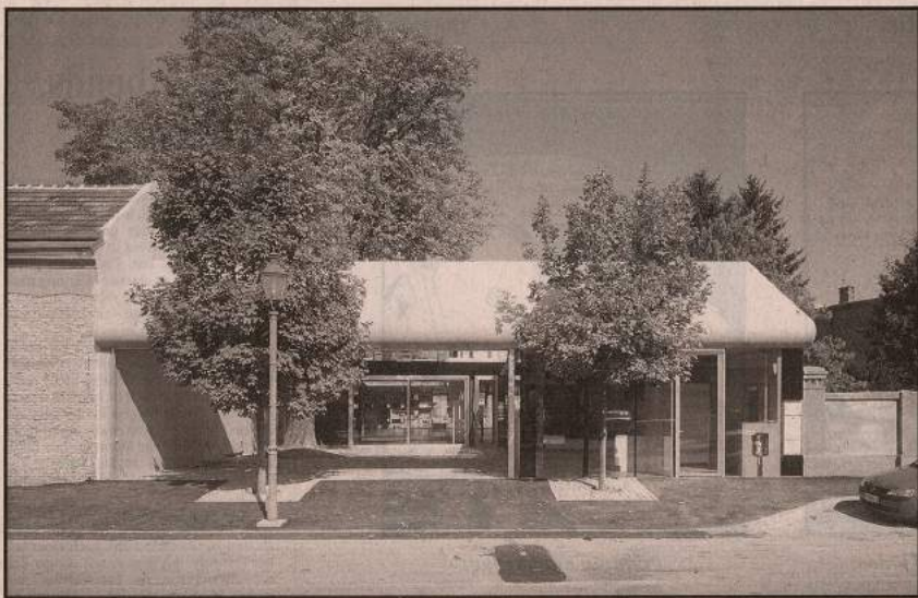
Fremdkörper im Zentrum von Aspern: Dachträger mit 15 Metern Spannweite aus Sichtbeton
